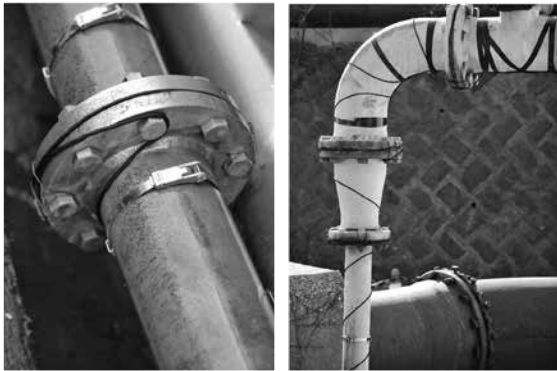
写真8 硫酸送酸管の立上部センサ
