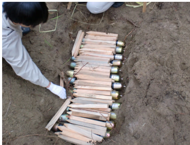
写真 9 ケーブル埋設状況（餌木の設置）
