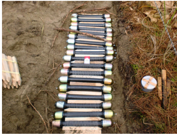
写真 8 ケーブル埋設状況
