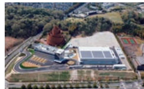
テクニカルセンター全景(空撮)
