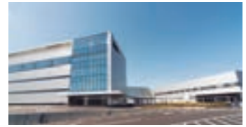
タツタテクニカルセンター
