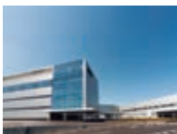
タツタテクニカルセンター
