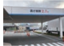
高さ制限の表示による接触事故防止対策
