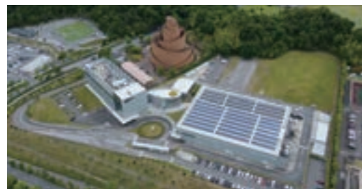
タツタ テクニカル センター
