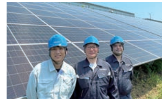
仙台工場に新設した太陽光パネル
