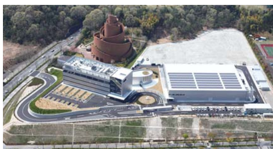
タツタテクニカルセンター
