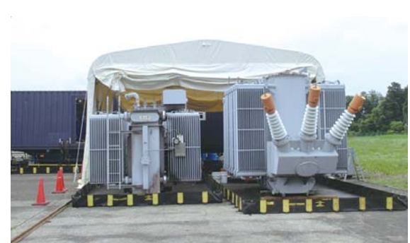
◇写真は、微量PCB汚染大型トランスの浄化実証試験の準備模様です。
