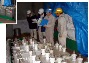
PCB保管状況の調査(大阪地区)
