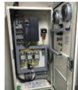
工場空調機をインバータ制御(制御盤)に更新
