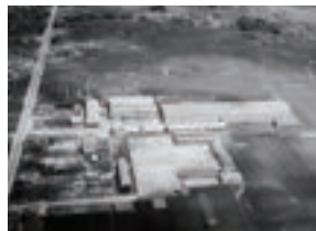
建設着工当時の若江工場
