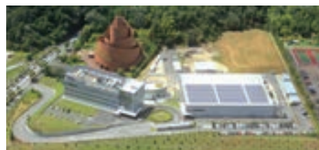
タツタテクニカルセンター
