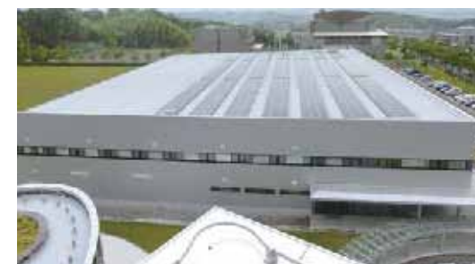
◇タツタテクニカルセンター工場棟に設置した太陽光発電モジュール
